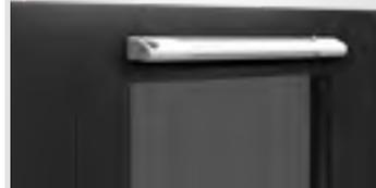
Aereco EMM - Feuchtigkeitsgesteuerte Lüftung
